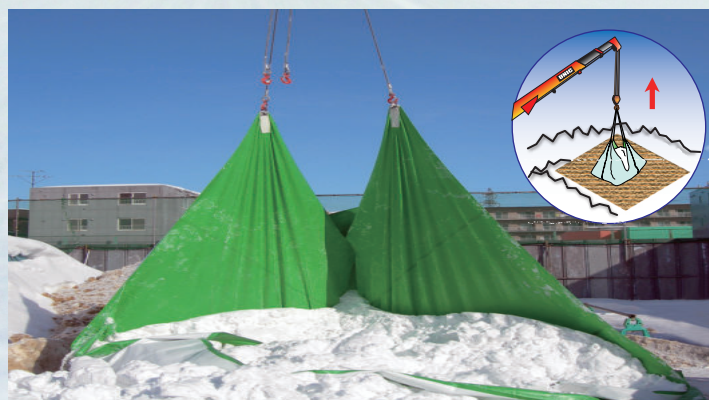
雪除けシートによる除雪作業例
