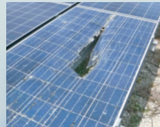
太陽光パネル点検
