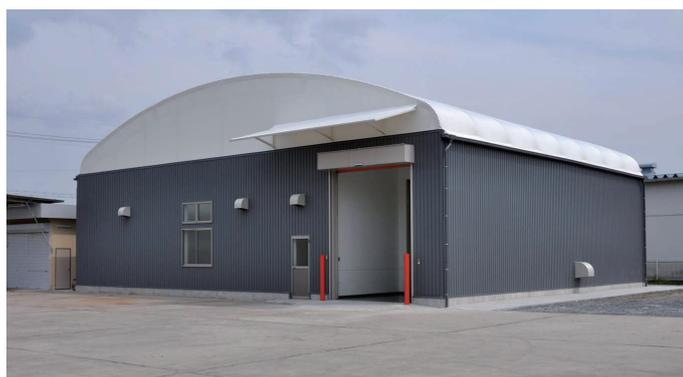
外壁に鋼板(ガルバリウム鋼板など)を採用した建築システム。耐久性・防犯性が格段にアップするうえ、膜屋根の最大特長である明るさはそのままなので、昼間の消費電力(照明)を抑え、省エネや、経費削減にも貢献します。
