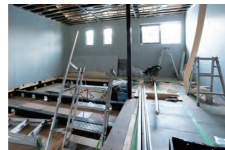
工事・建設現場
