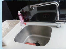
給湯室周りに
