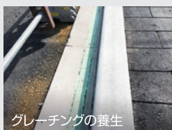
グレーチングの養生
