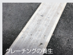
グレーチングの養生
