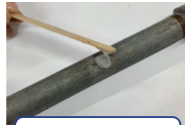
漏洩箇所に塗布
